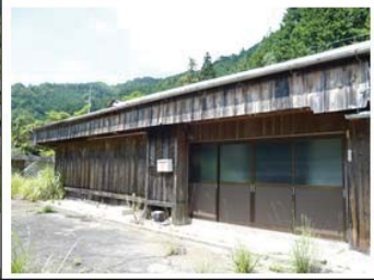
空き家を活用した宿泊所
